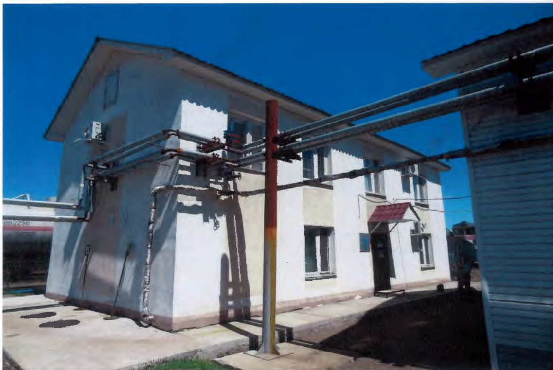
Рисунок 4.3.1.1 – Общий вид фасадов Б-А, 1-4
