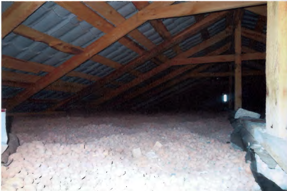
Рисунок 4.5.3.1.1 – Общий вид чердачной крыши
